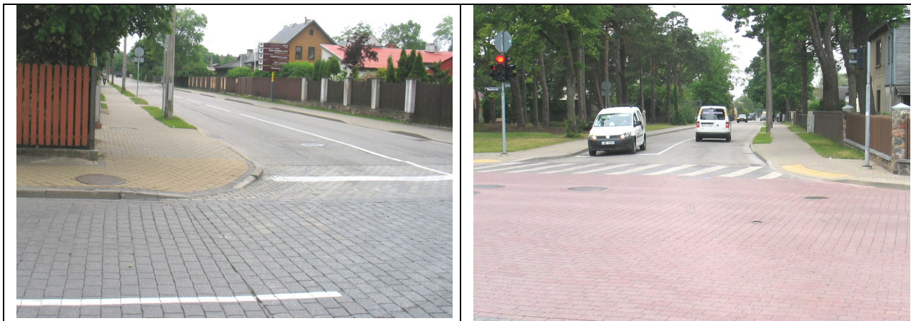
1.5.8. Lietus ūdens atvade Kroņa ielai ir izbūvēta, bet Kroņa un Loču ielas krustojumā segumam nav nodrošināti kritumi uz gūlījām (lietus laikā applūst brauktuves posms).
